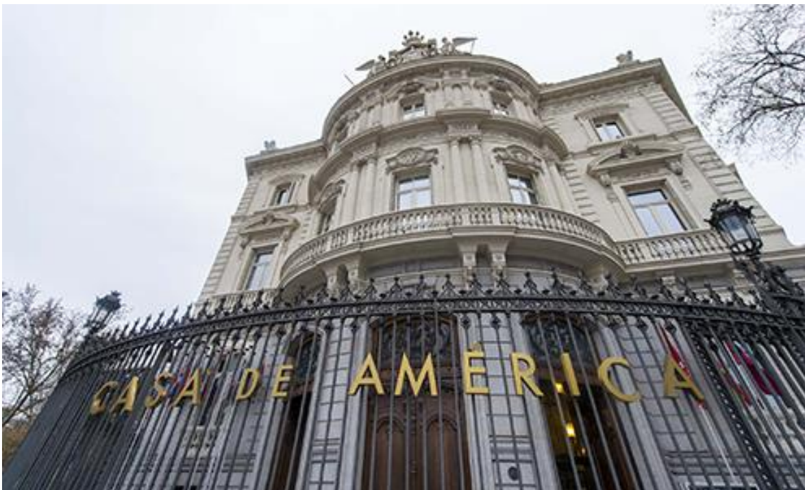
Fachada principal de la Casa de América, en Madrid.
