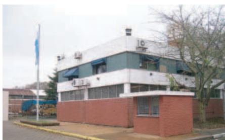
Centro de Capacitaci n Portuaria (CENCAPOR) Comit e de Transferencias Gerencia Control de Terminales Servicio M dico Edificio 4
