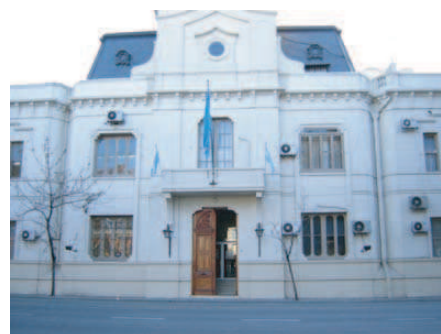
Administraci n General de Puertos S.E. Casa Central Edificio 1
